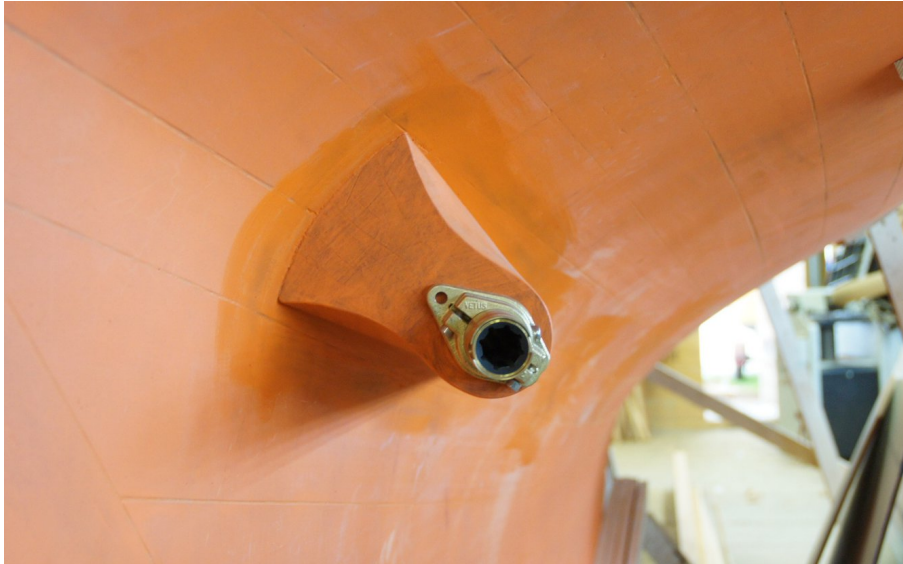
Exemple de ligne d'arbre latérale sur un yacht classique en construction
